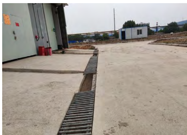
厂区一般废物暂存间和危废暂存间前导流沟
