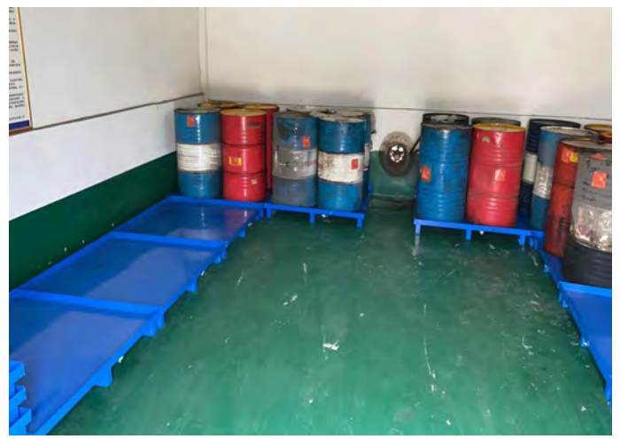
危废间内部现状
