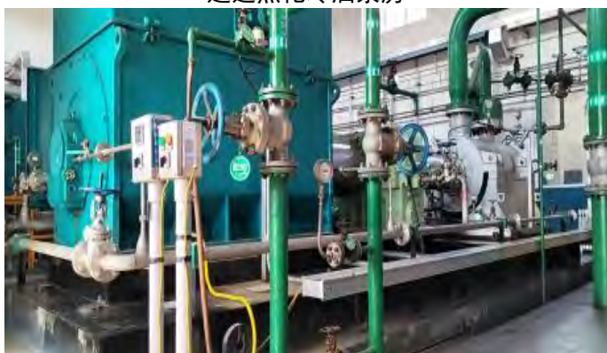
延迟焦化高压水泵房
