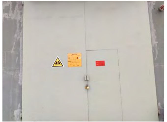
厂区危险废物暂存间 (1)
