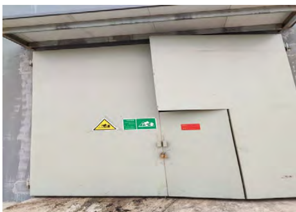
厂区一般废物暂存间
