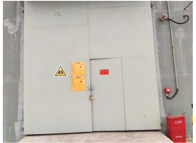
厂区危险废物暂存间 (3)
