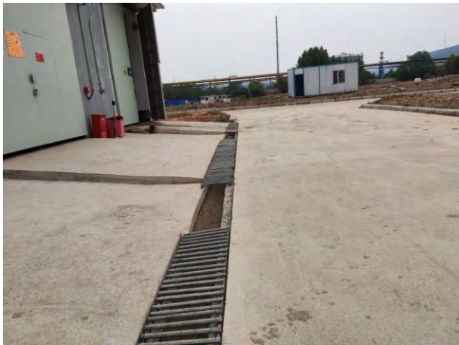
固废贮存设施前导流沟
