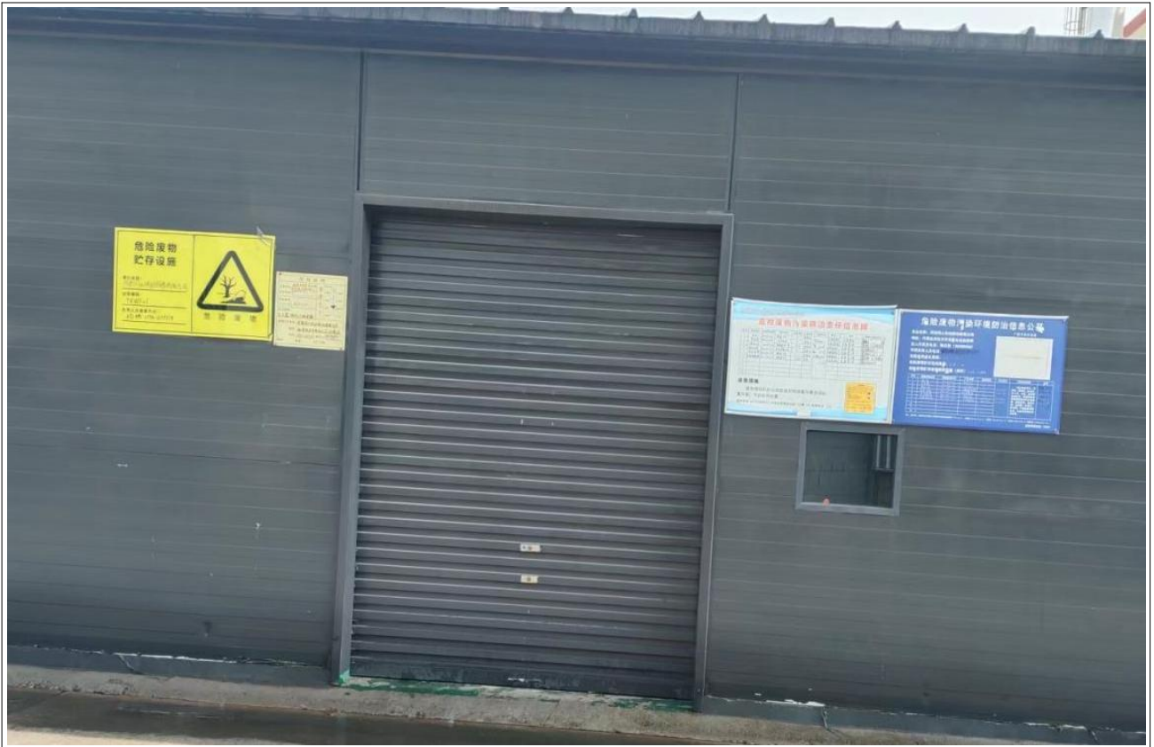
危险废物暂存间
